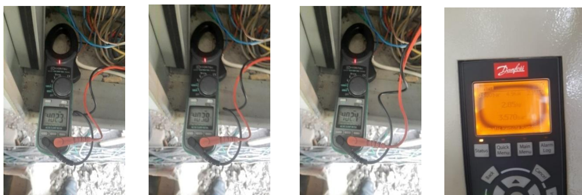
Gambar 5. (a) Clamp meter pengukuran tegangan dan arus motor DOL dan (b) Monitor VFD parameter pengukuran motor dengan VFD
